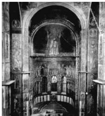
92. Вітварна арка з двома регістрами незаписаних фресок, відкритими в процесі демонтажу іконостасу. Світлина 1893 р.
