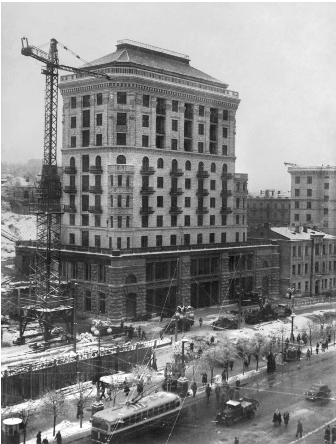
Будинок на Хрещатику, 27. Реалізація будівництвом 1952 рік
