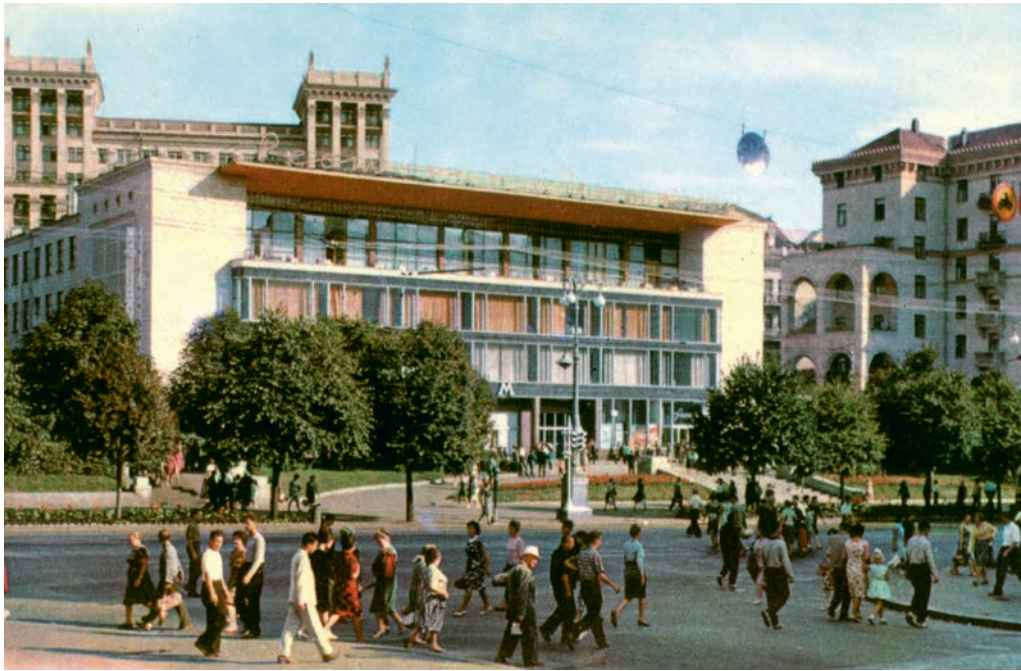
Наземний павільйон станції метро «Хрещатик» З листівки 1960-х років
