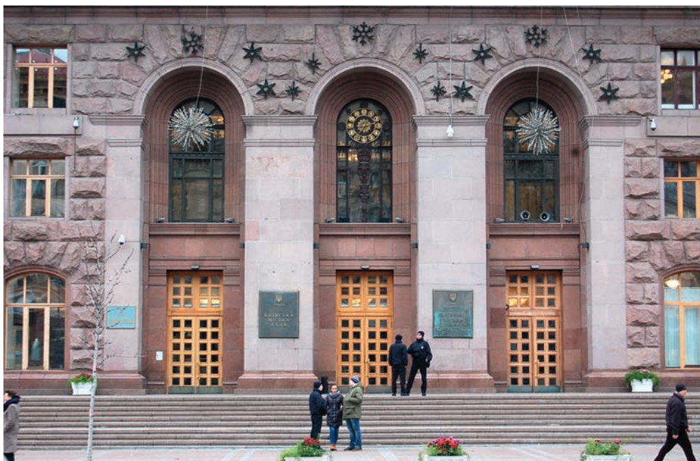
Величні арки головного входу до міськради авторства архітектора О. Малиновського. Фрагмент фасаду з пілястрами та розвиненим карнизом
