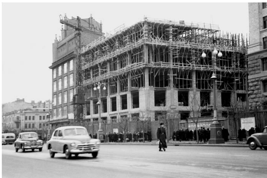
Етапи розширення будівлі ЦУМу
