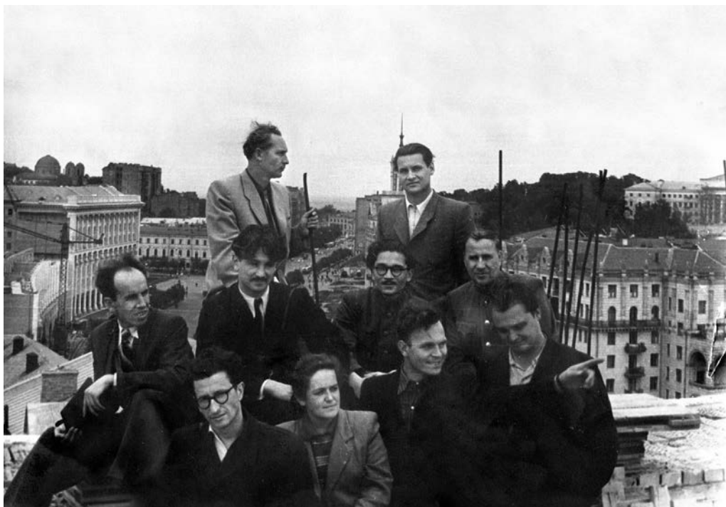
Архітектор О. Малиновський (стоїть ліворуч) з колегами на даху міськради під час будівництва 1955–1956 роки
