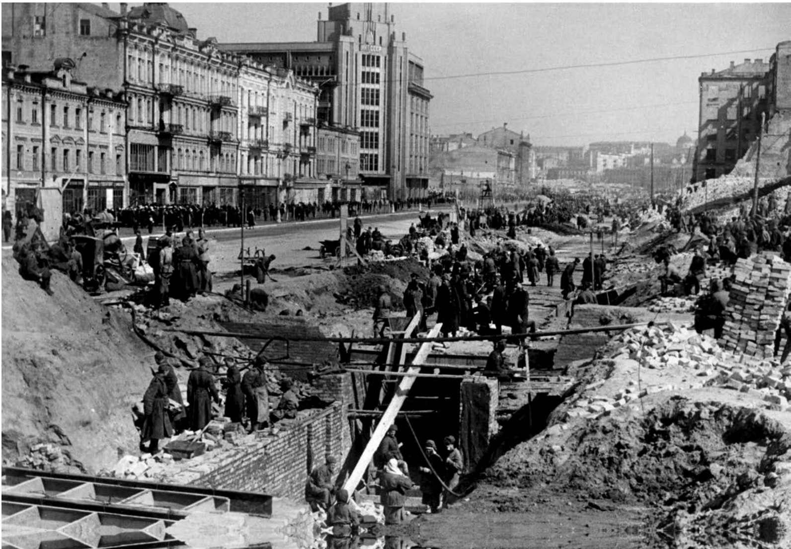
Прокладання хрещатицького колектора 1944 рік
