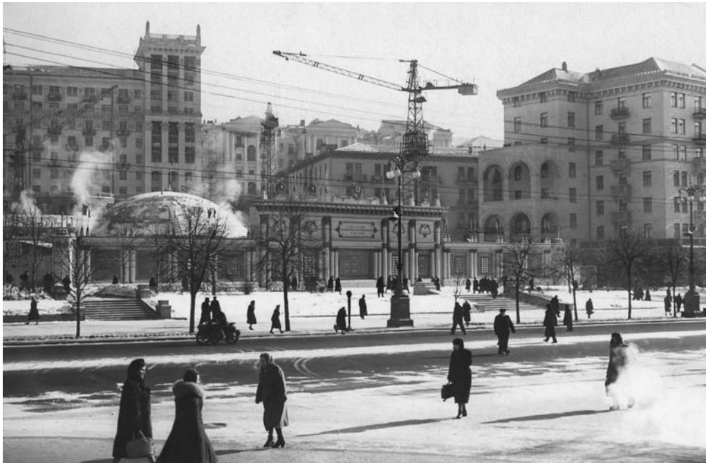
Дошка пошани на ділянці майбутньої станції метро «Хрещатик» 1957 рік
