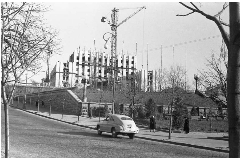
Будівництво готелю «Москва». Вигляд з боку вулиці Жовтневої революції 1958 рік
