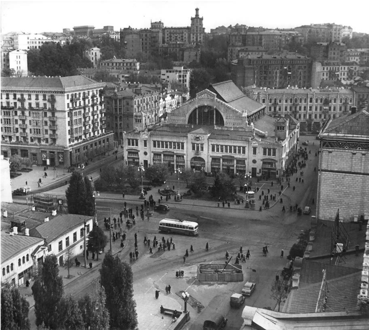
Загальний вигляд Бессарабської площі 1959 рік
