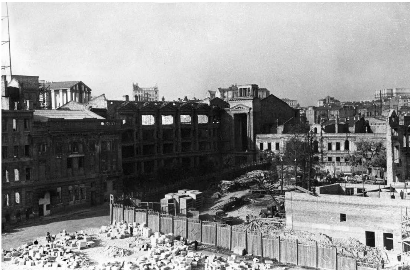
Будівельний майданчик на ділянці колишнього Музичного провулку Кінець 1940-х років
