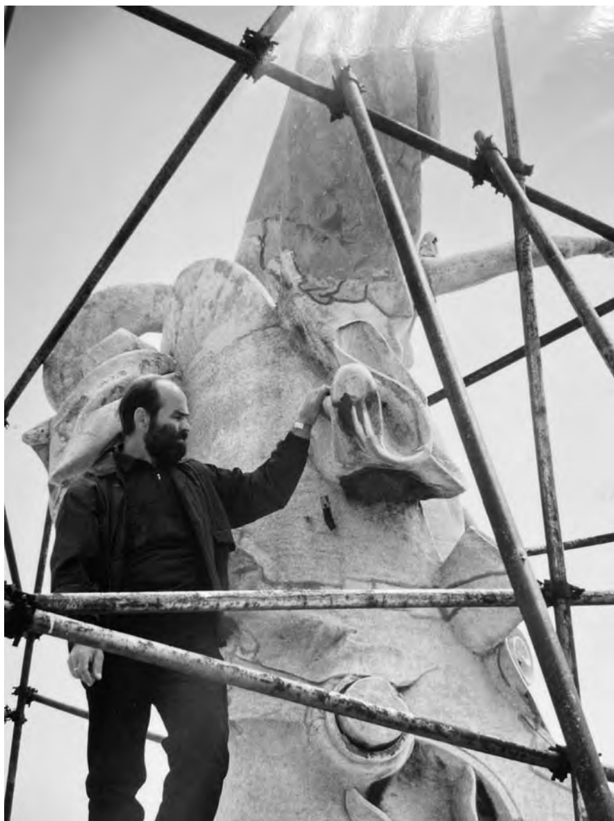
24.05.1997. Реставраційні роботи скульптурного оздоблення на даху Одеського оперного театру
